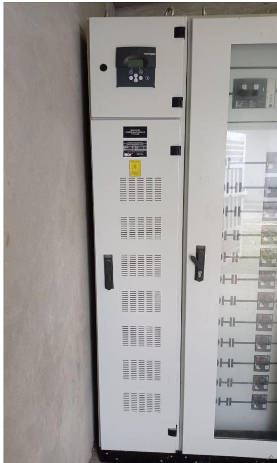
*Fotografía 17. Celda de controlador de banco capacitivo.*
