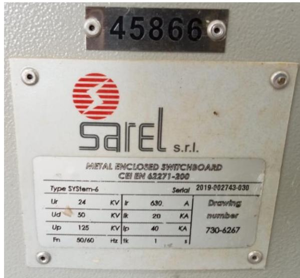
Fotografía 14. Información celda seccionamiento planta Loma.
