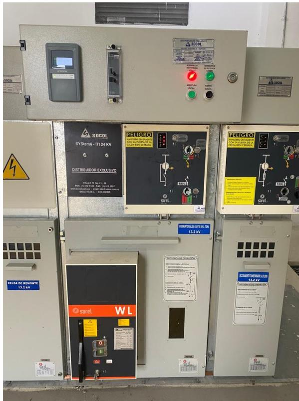
Fotografía 10. Celda interruptor de salida planta Bocatoma-Playita.
