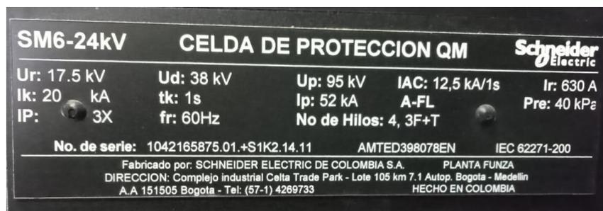
Fotografía 27. Información de celda de seccionador.
