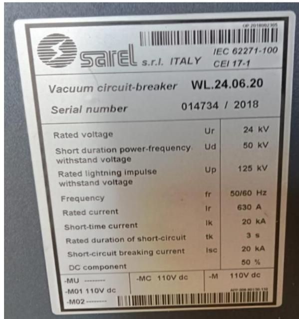
Fotografía 12. Información de interruptor de celda interruptor de salida planta Bocatoma-Playita.
