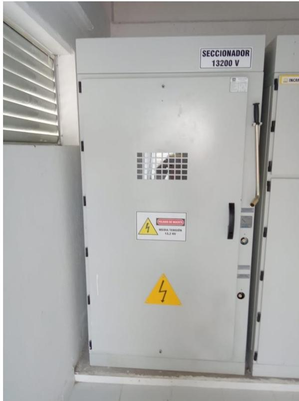
Fotografía 32. Celda de seccionador.
