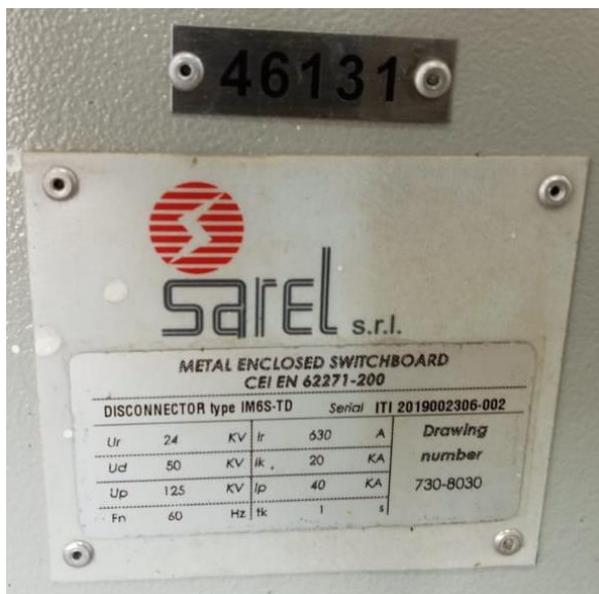
Fotografía 11. Información de celda interruptor de salida planta Bocatoma-Playita.
