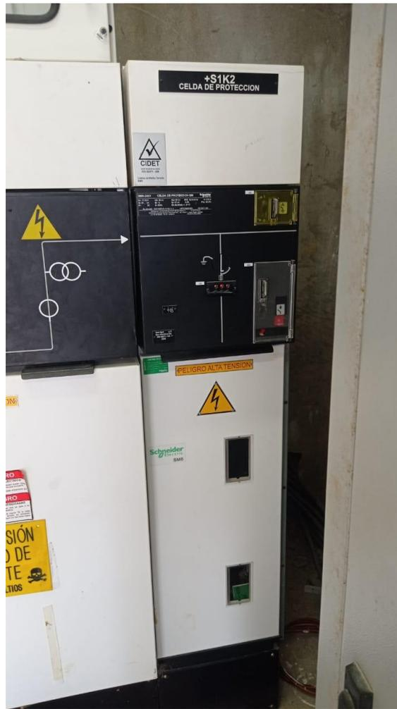
Fotografía 26. Celda de seccionador.
