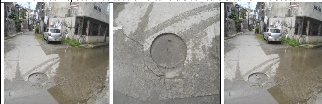
Pozo de inspección ubicado en la carrera 5b con calle 13 barrio Niño Jesús
