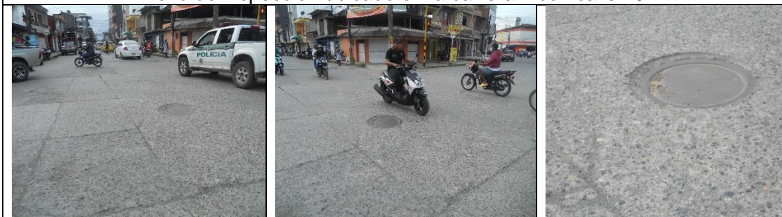
Pozo de inspección ubicado en la carrera 7 con calle 30
