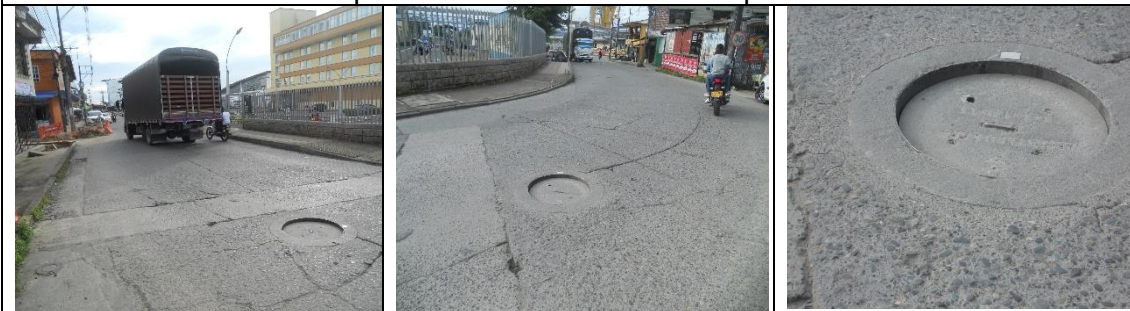
Pozo de inspección ubicado avenida aeropuerto calle 30 diagonal al centro comercial
