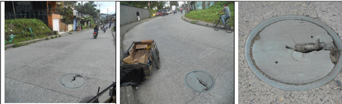
Pozo de inspección ubicado avenida aeropuerto calle 30
