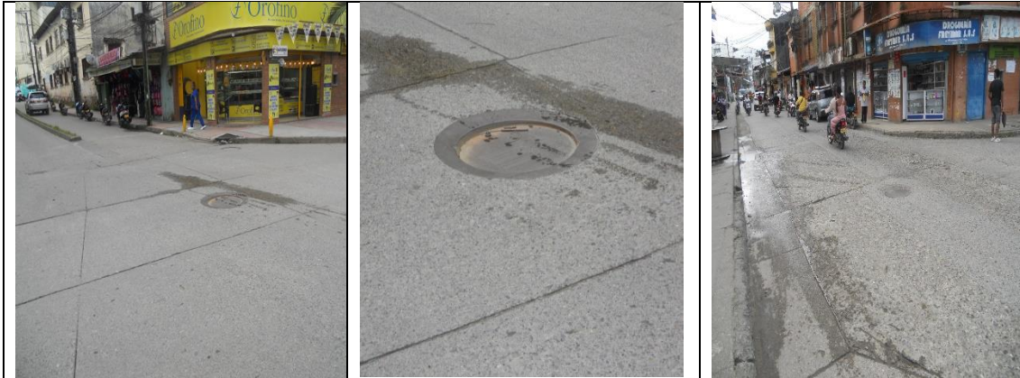
Pozo de inspección ubicado en la carrera 3 con calle 25
