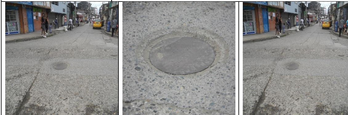
Pozo de inspección ubicado en la carrera 6 con calle 24
