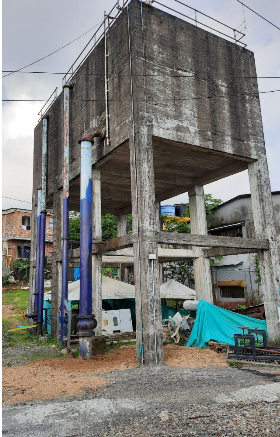
Fotografía 4. Estructura exterior tanque de almacenamiento de Playita.
