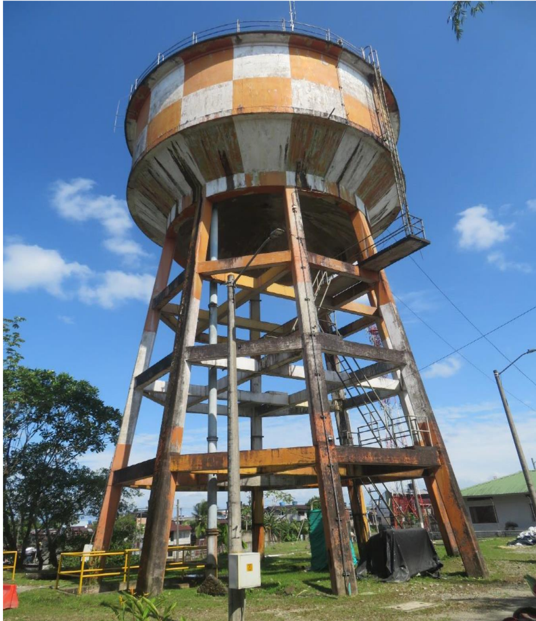
Fotografía 1. Estructura exterior tanque de almacenamiento de la Loma.
