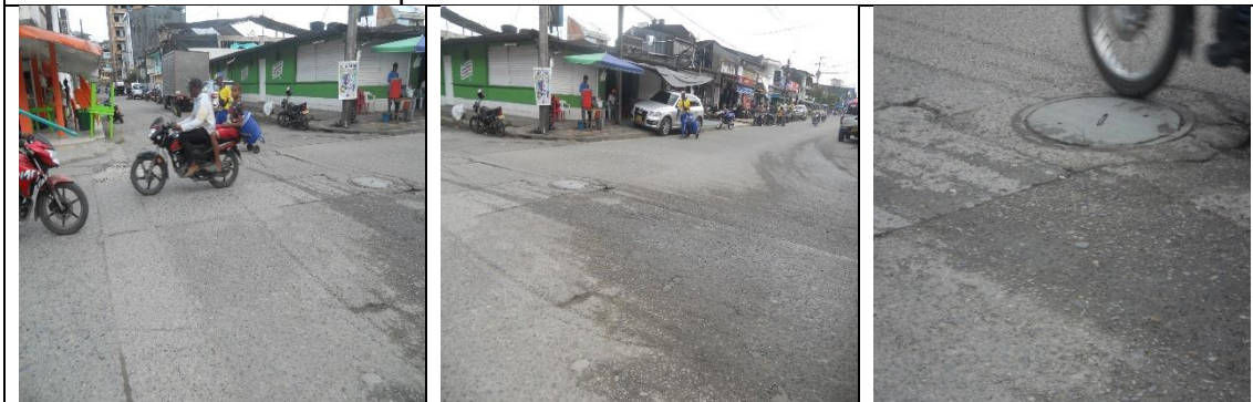
Pozo de inspección ubicado en la carrera 7 con calle 29
