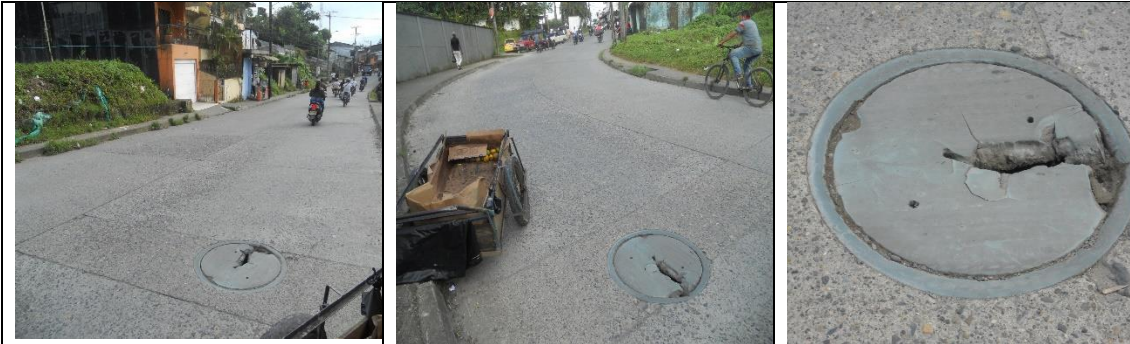
Pozo de inspección ubicado avenida aeropuerto calle 30
