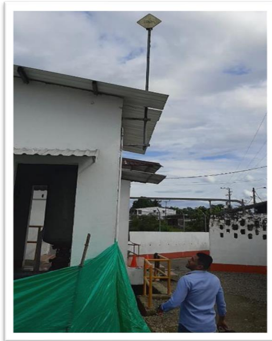
Antena para sistema de comunicaciones Bocatoma
