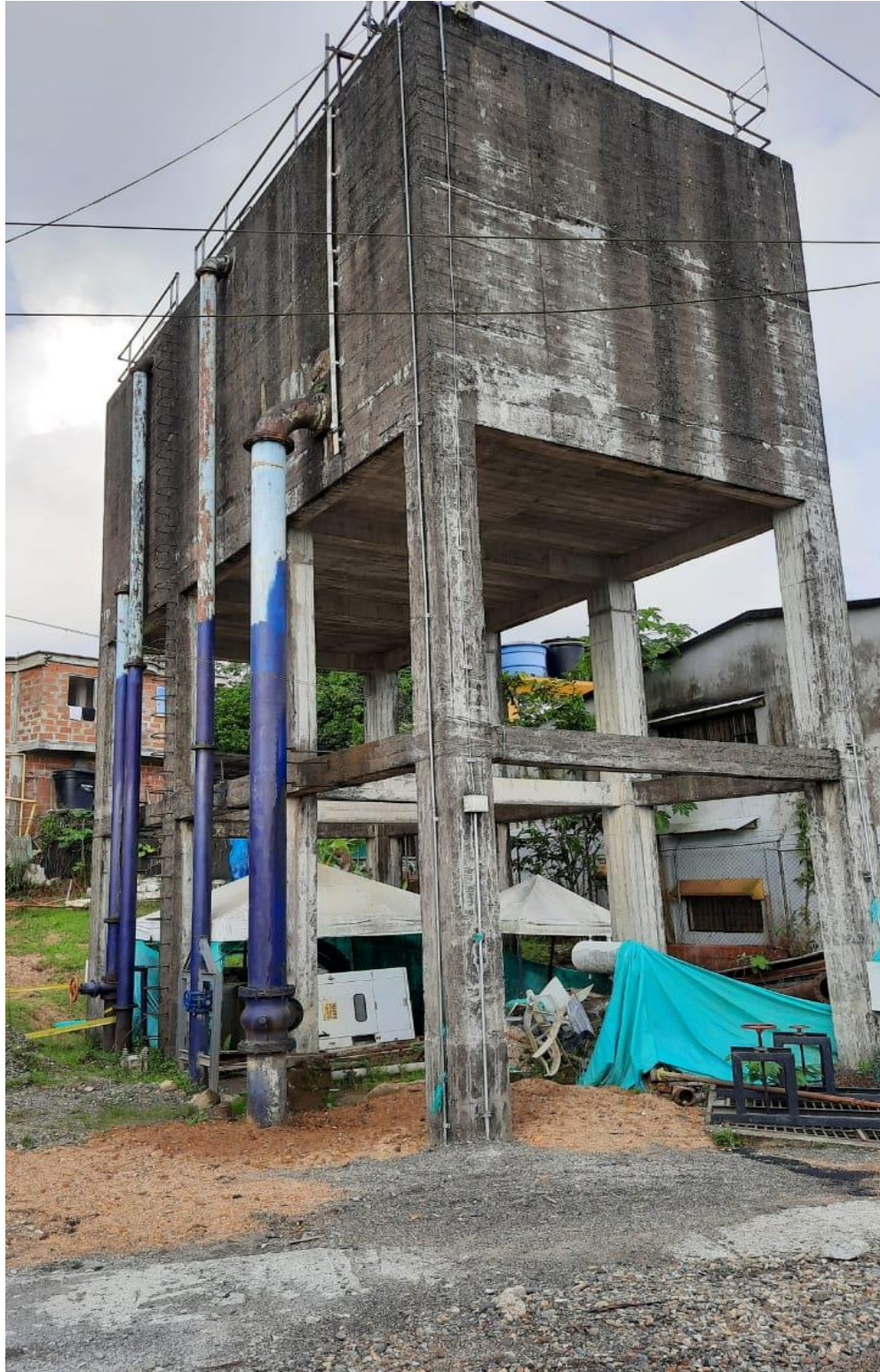
Fotografía 4. Estructura exterior tanque de almacenamiento de Playita.
