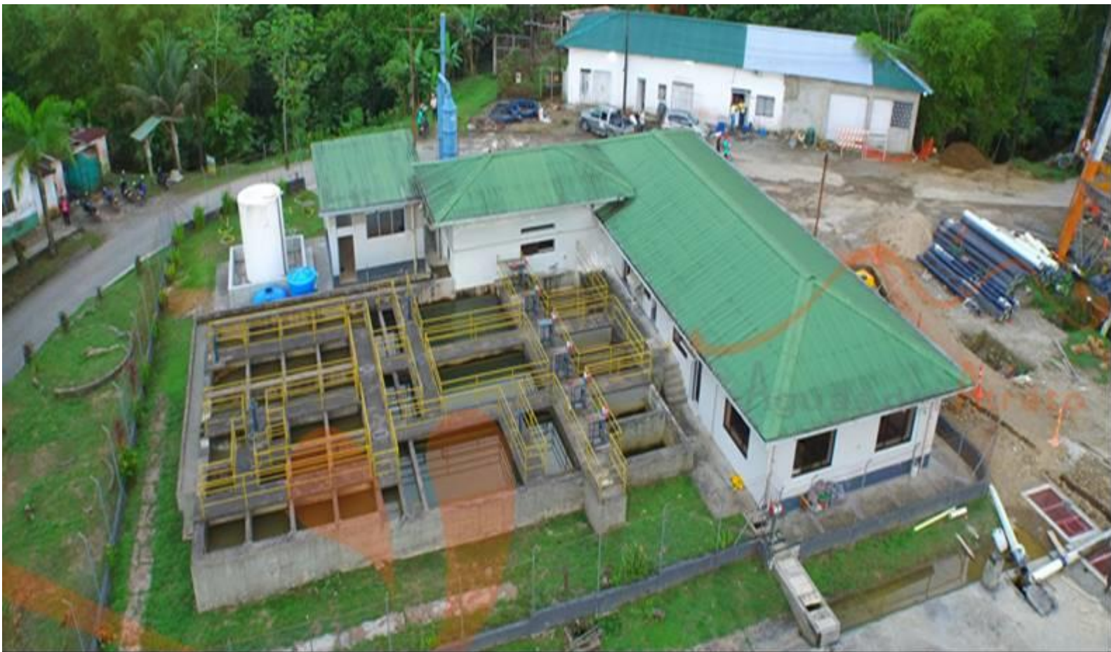
Fotografía N°2: Planta de tratamiento – Loma
